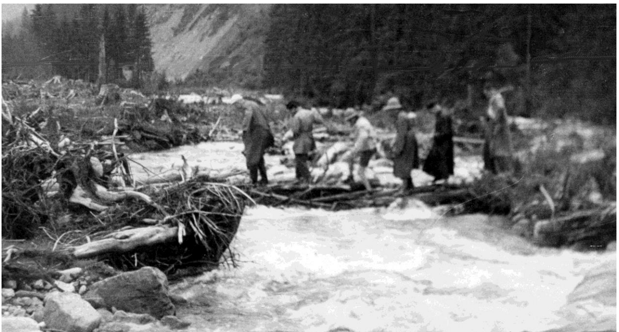
Cesta domů po povodni
